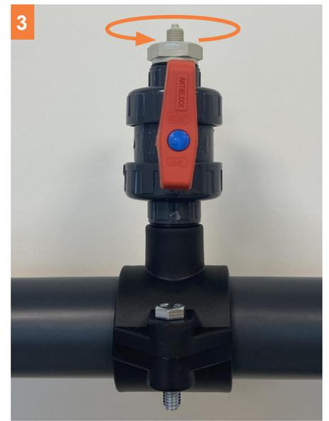
Auf das Gewinde von Teil C muss Teflon ( $\approx 8$  Umdrehungen) aufgetragen werden, bevor es auf das Ventil D geschraubt wird.
