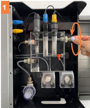
1 Schrauben Sie den Anschluss vom Auslass ab
