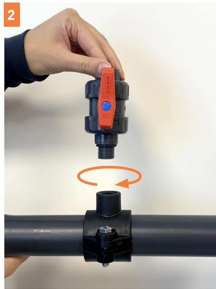
Schrauben Sie das Ventil auf die Manschette, wobei Sie die Reihenfolge der Komponenten von Teil F bis Teil D einhalten.
