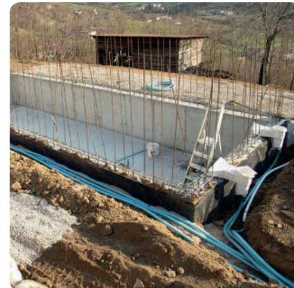
**Tuyau spiralé pour les systèmes souterrains sous pression des piscines et des bains à remous, résistant au chlore, à l'écrasement et à la fissuration.**
