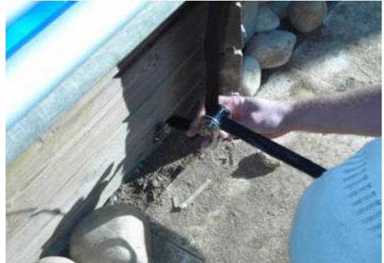
Coté bloc, tendre les cliquets de façon à mettre la couverture en butée sur le bloc.
