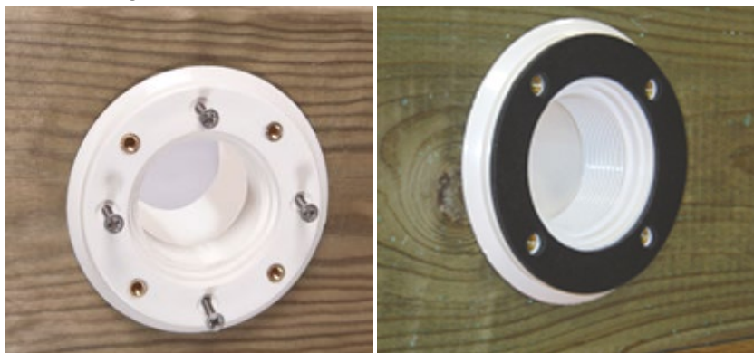
Abbildung 24 – Montage der Ausstoßdüse und seiner Dichtung
