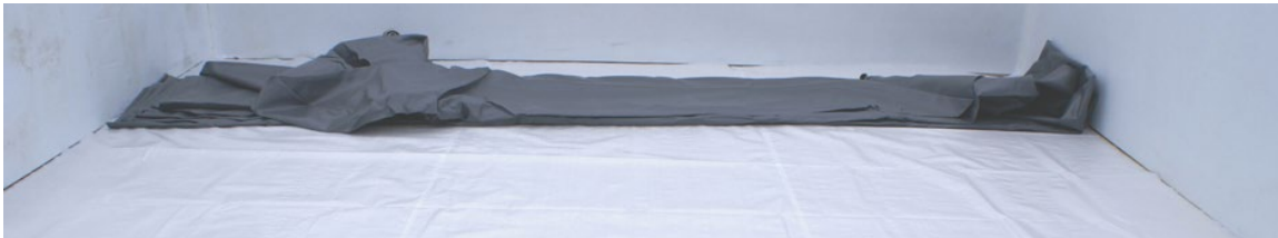
Abbildung 33 – Entfalten der Folienauskleidung
