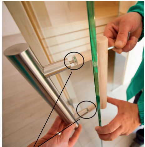
Applicare rondelle di plastica nelle maniglie Nirosta
