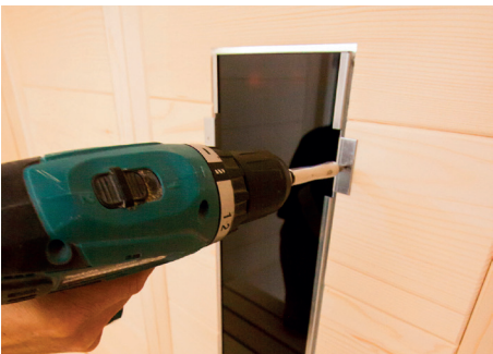
4 parafusos de 3 x 20 mm
