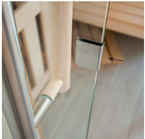
Kunststoff Beilagscheibe bei Niro-Griff beilegen
