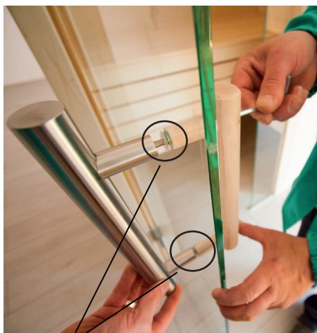
Pose des rondelles de calage en plastique pour poignée inox
