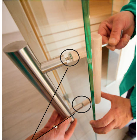
Kunststoff Beilagscheibe bei Niro-Griff beilegen
