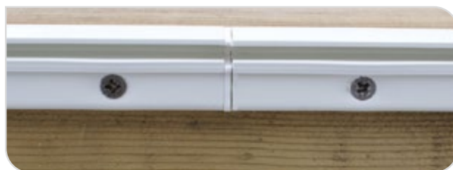
Figure 28 – Rail posé affleure de la structure
