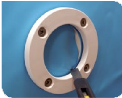
Figure 54 – Découpage du liner
