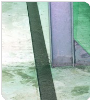
Figure 15 – Déroulage des bandes bitumeuses
