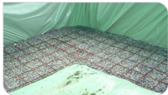
Figure 3 – Fond de la fouille
