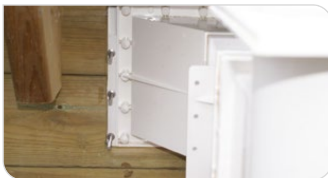
Figure 34 – Verrouillage du skimmer
