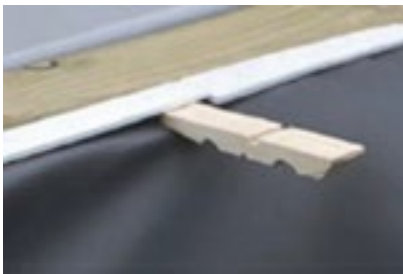
Abbildung 28 – Verklebung der Folienauskleidung mithilfe der halben Wäscheklammern
