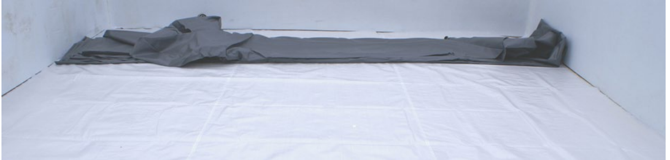
Abbildung 27 – Entfalten der Folienauskleidung
