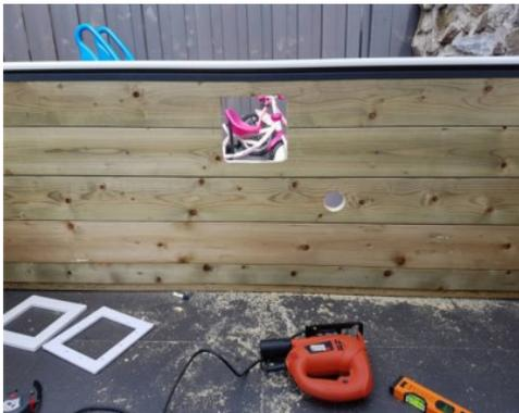
**Skimmer Ausschnitt:** Bitte halten Sie den Skimmer mittig an die Innenseite des Pools und zeichnen den Ausschnitt mithilfe eines Bleistiftes an. Der Abstand nach oben sollte nicht weniger als 5 cm betragen da sich der Skimmer-Deckel später sonst nicht mehr entnehmen lässt. Anschließend sägen Sie den Ausschnitt mit einer Stichsäge heraus. Das Loch sollte 1–2 mm größer sein als der Skimmer-Korpus.
