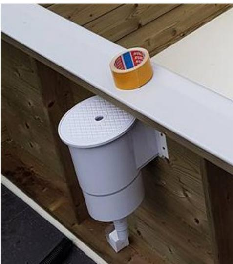
**Skimmer Montage:** Bitte schieben Sie den Skimmer von der Außenseite des Pools in die Öffnung im Pool und schrauben ihn mit den Edelstahlschrauben am Pool-Korpus fest.
