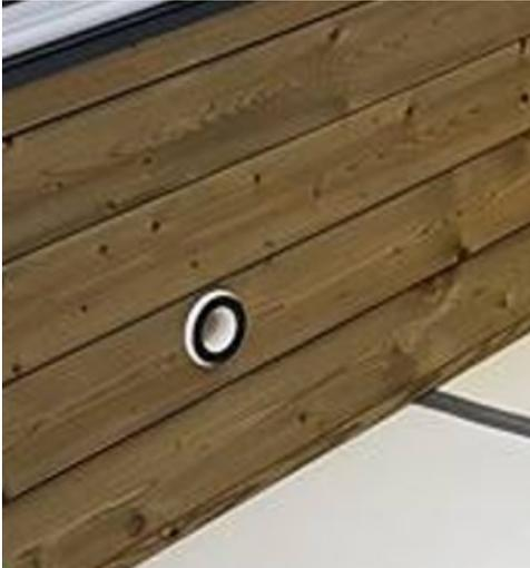
**Einlaufdüse:** Markieren Sie einen Punkt, der sich ca. 15–20 cm neben dem Skimmer und mittig in der Bohle unter dem Skimmer-Ausschnitt befindet. Nun setzen Sie eine Lochsäge mit 60 mm Bohrkronen dort an und sägen das Loch für die Einlaufdüse in die Holzwand.
