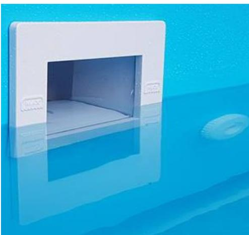
**Folienausschnitte:** Schneiden Sie die Folie von Skimmer und Einlaufdüse mit einem Cuttermesser aus und füllen den Pool bis Mitte Skimmer auf. Montieren Sie nun die Blenden für Skimmer und Einlaufdüse. Nachdem die Schläuche und die Sandfilteranlage vollgelaufen sind können Sie die Sandfilteranlage in Betrieb nehmen.
