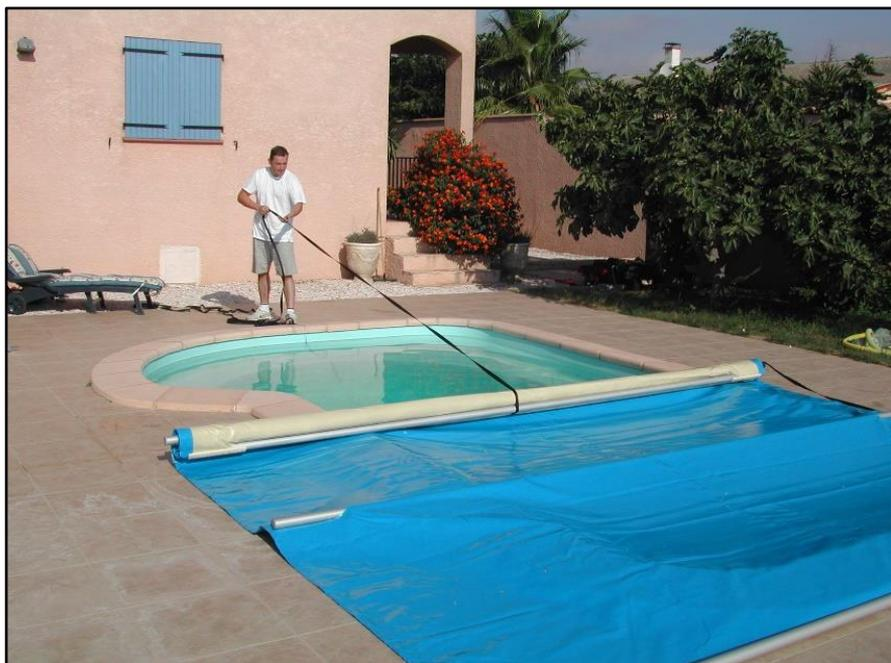
Par la suite, une fois la piscine totalement recouverte, enfiler toutes les sangles dans les cliquets, et effectuer la tension de la couverture comme lors de l'installation.
