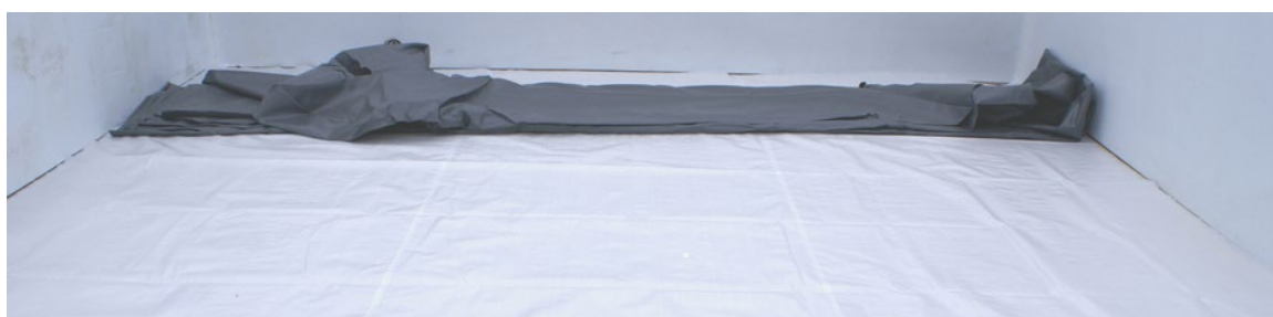
Abbildung 33 – Entfalten der Folienauskleidung
