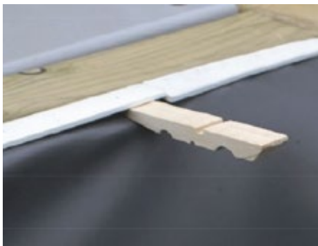
Abbildung 32 – Verteilung der Folienauskleidung mithilfe der halben Wäscheklammern
